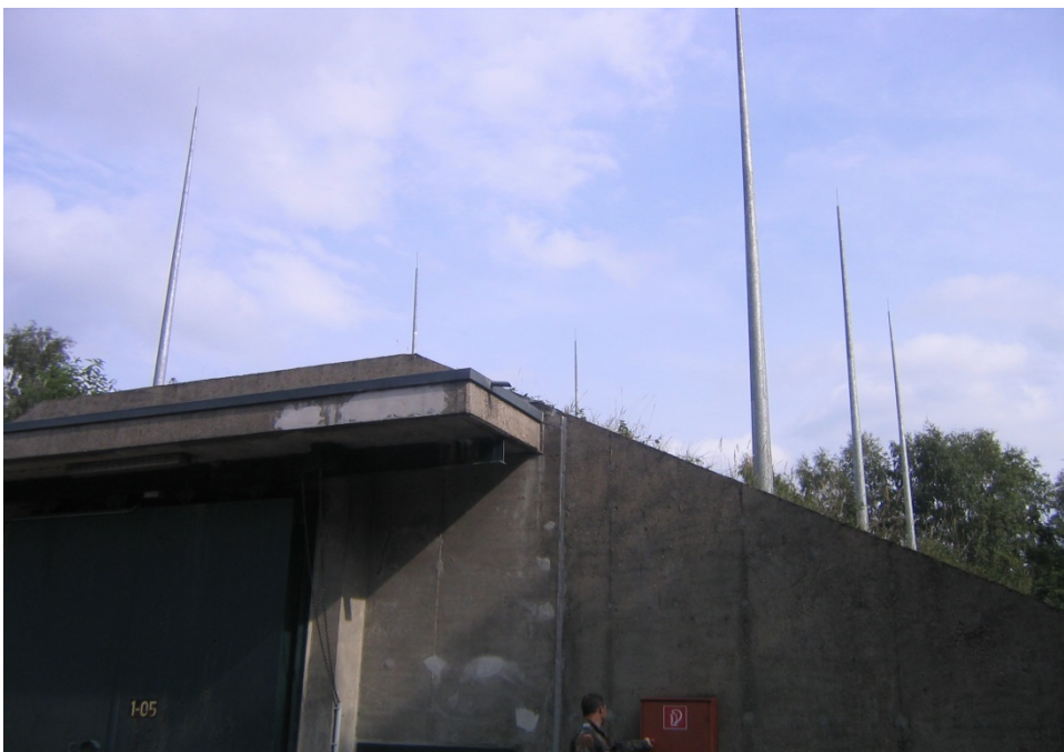
Abb. 3-1: Erdeingedecktes Munitionslager mit seitlichen Fangstangen
