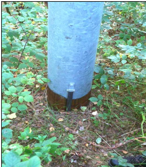
Abb. 3-3: Metallene Fangstange; am Fußpunkt Verbindung des Bandeisens zum Ringerder
