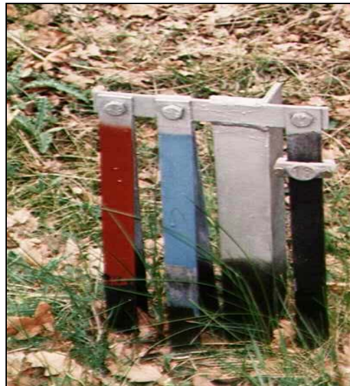
Abb. 3-4: Lösbare Verbindung zweier Ringerder für Messzwecke
