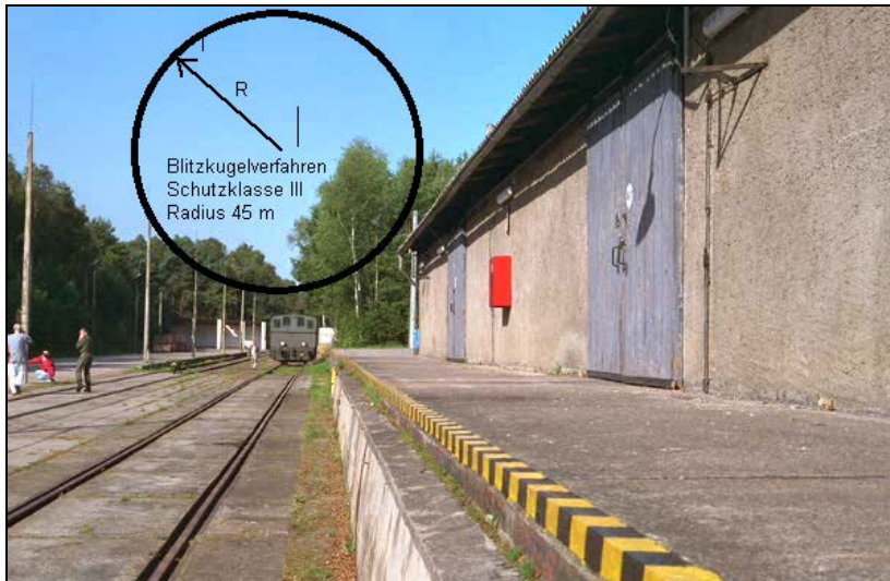
Abb. 3-5: Munitionsverladestation mit Masten in der Funktion als Fangstangen (Blitzkugel nicht maßstabsgerecht)
