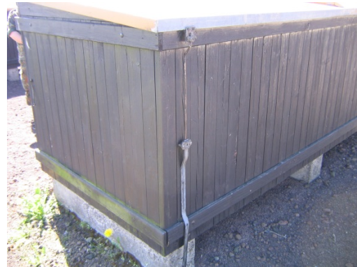
Abb. 3-8: MBH Holz (Typ 170) – Rückansicht mit Ableitung von Zinkblechdach zu Erdungsanlage
